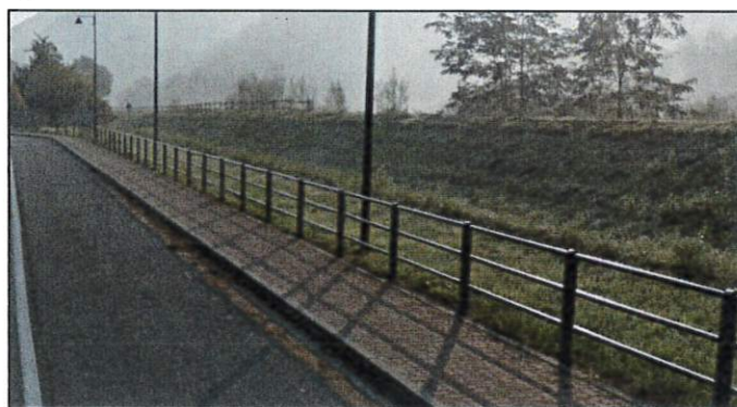
Figura 85 – Argine a protezione dalle dinamiche di esondazione del Sessera, in sinistra, in Comune di Pray
